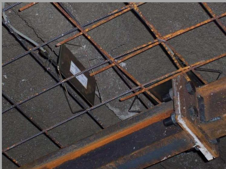
La cella è costituita da un doppio piatto metallico di forma rettangolare con un'intercapedine saturata con olio disaerato. La cella è connessa al terminale di misura (trasduttore di pressione) mediante un tubo idraulico ed è dotata di una valvola di ripressurizzazione per l'attacco alla pompa manuale in caso di perdita di carico. Le celle possono essere completamente immerse nel getto in calcestruzzo e sono idonee alle misure secondo la metodologia NATM.
